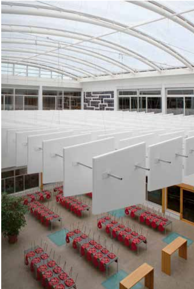
Fotografische Dokumentation der realisierten Baffle-Decke
